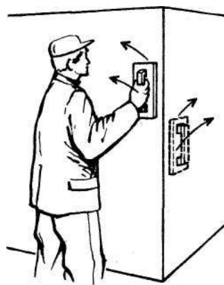
Рис. 208. Отделка углов при оштукатуривании поверхности
