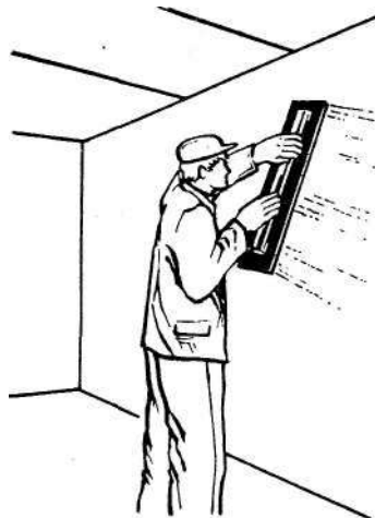
Рис. 210. Выравнивание, затирка оштукатуренной поверхности
