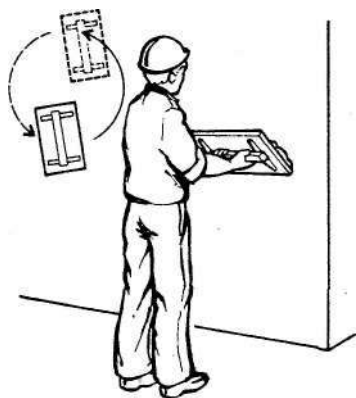
Рис. 207. Применение полутерка при доводке поверхности
