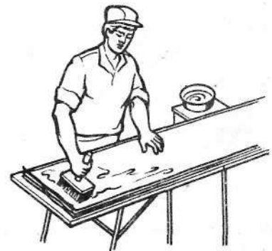
Рис. 231. Нанесение клея на обои
