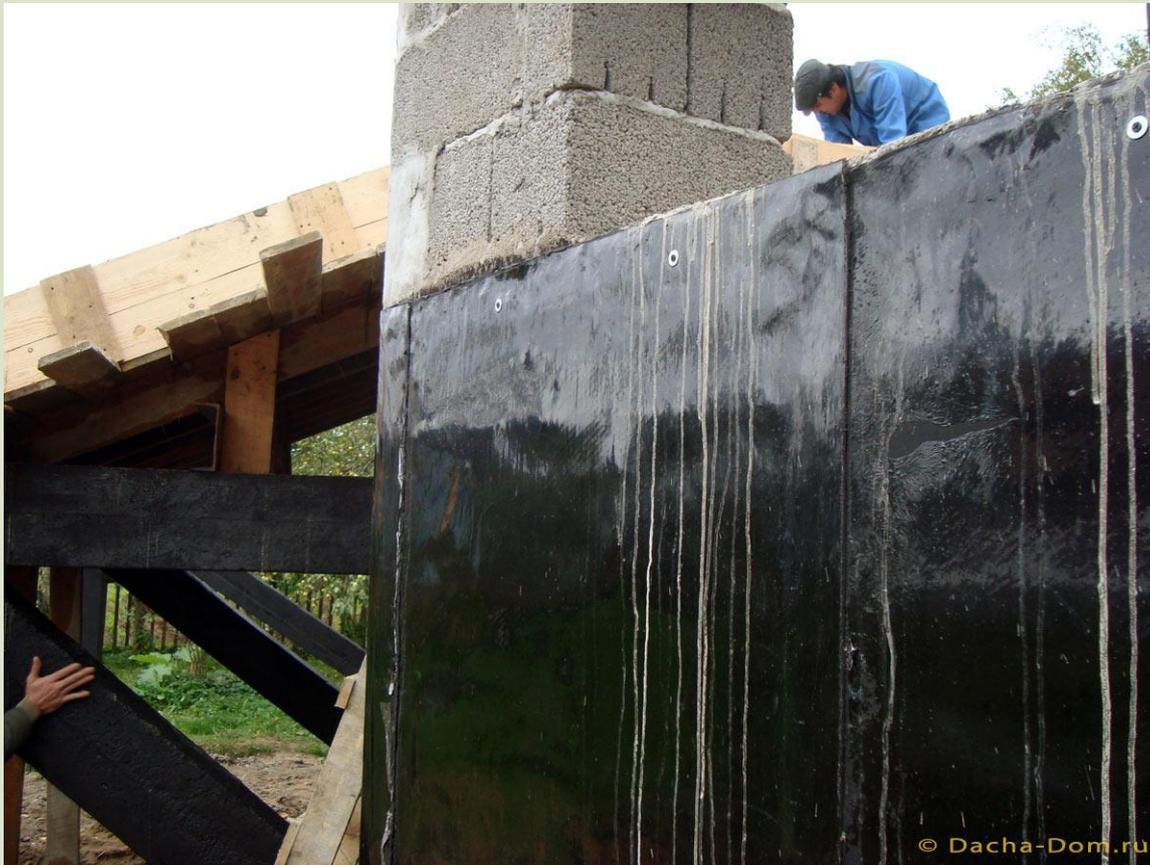
*\* На фото пластины гидроизоляции наплавлены неправильно – вертикально. Они должны наплавляться горизонтально, начиная с нижней части, чтобы верхние пластины ложились с нахлестом на нижние.*
