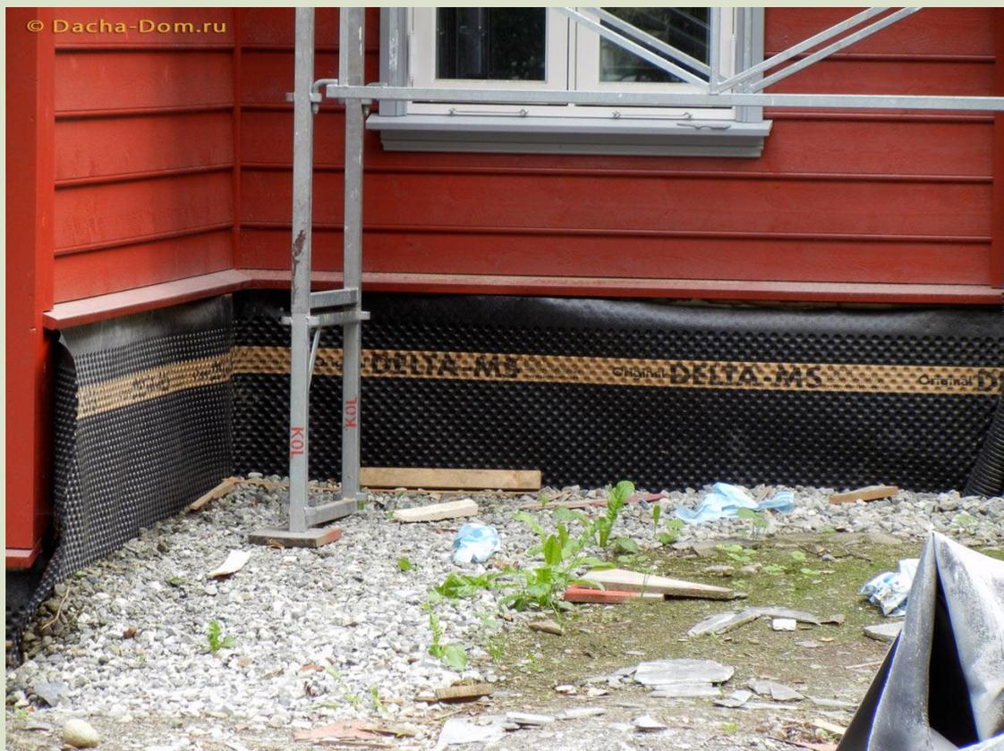
Полимерные листы гофрированной стороной крепят к изолируемой наружной стене горизонтальными рядами, снизу вверх так, чтобы водоотводящие каналы располагались вертикально. Величина нахлеста в вертикальных и горизонтальных швах должна быть не менее **10 см**. Соседние листы могут быть склеены, например, полосами гидростеклоизола так, чтобы грунт при обратной засыпке не попадал в водоотводящие каналы.
